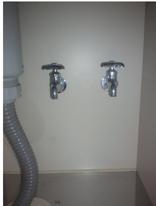
④台所下にある蛇口を洗面器等を用意した上で開けます
