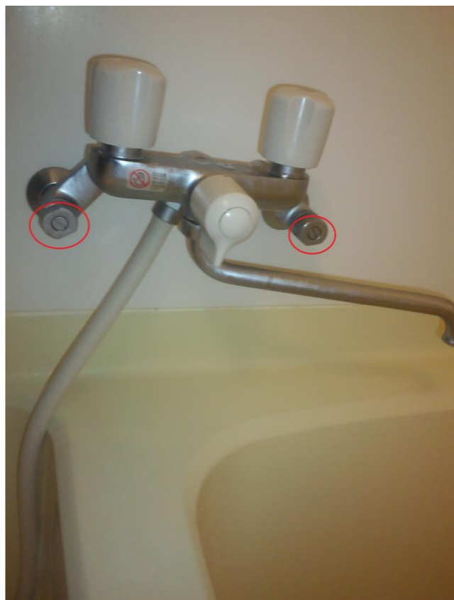
⑧UBの混合水栓です 水・お湯ハンドルを開けてシャワーホースを床に置き、赤丸印のネジを緩めます
