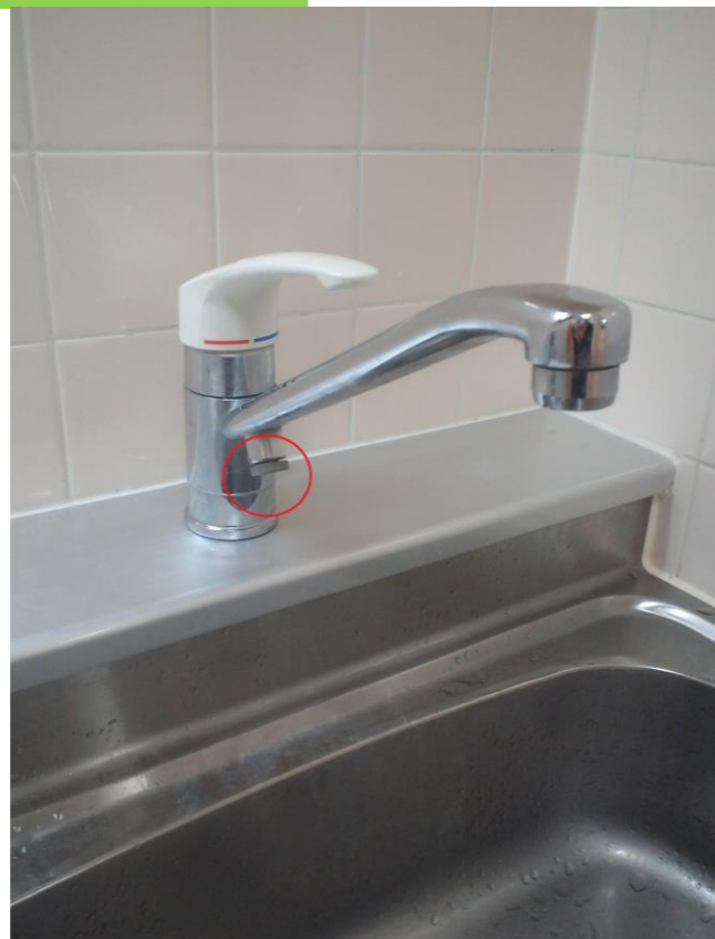
②台所のレバーハンドルを真ん中の位置で上に上げて水を出します ③赤丸印のネジを緩める
