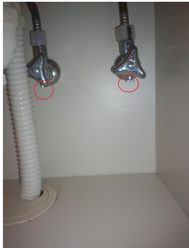
⑦洗面台下の赤丸印のネジを2ヶ所緩める。口が広いペットボトル等を用意するとやりやすいです。
